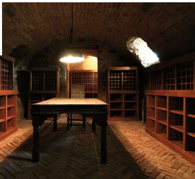
Сводчатый кирпичный зал дегустации вин, расположенный в винном погребе господского дома. Вдоль стен размещены сосновые полки, обработанные красноватой морилкой.
